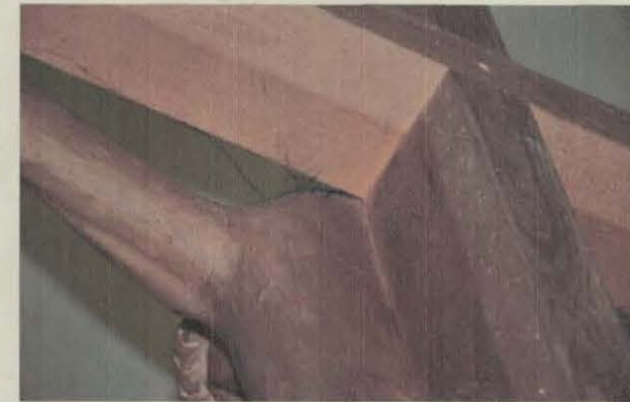
Abb.4: zahlreiche frische Ausflüglöcher holzerstörender Insekten, Oberflächenschmutz
